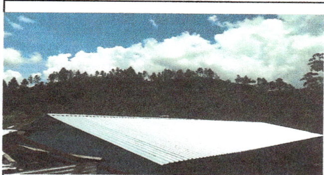
Foto 1: Sustitución de Cubierta de láminas troqueladas calibre 26.
