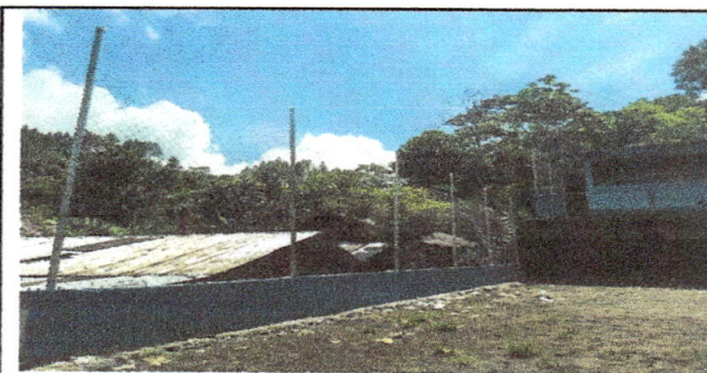
Foto 5: Culminación de circulación con tubos y mallas galvanizadas.
