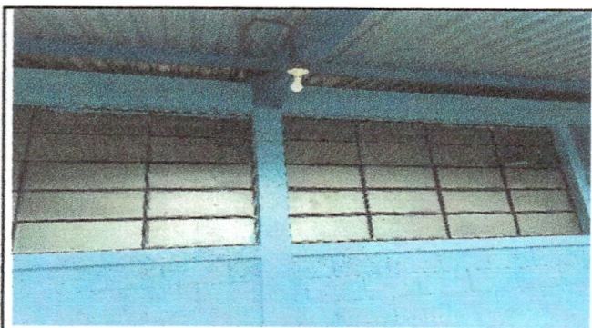
Foto 3: Sustitución de vidrios quebrados por nuevos.
